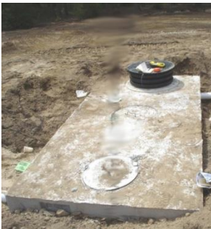
Slika 5. Izgled izgrađene septičke jame
