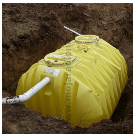
Slika 21. Plastične (alternativne) septičke jame
