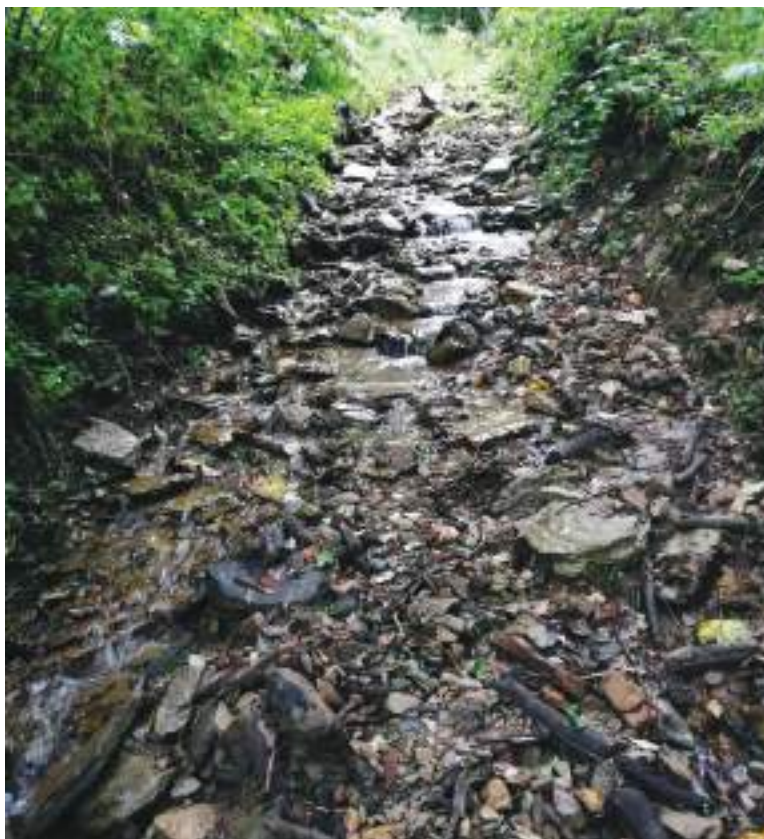
Slika 7. Ekstreman uticaj traktorskog puta na odvodnju površinskih voda (kategorija V) / Figure 7. Extreme impact of skid roads on the drainage of surface water (category V)
