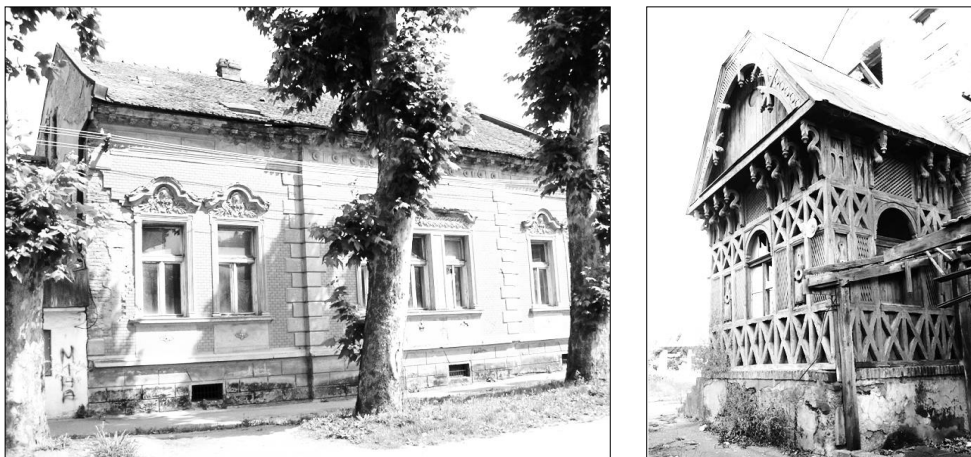
Slika 4. Upravna zgrada danas. Ulična fasada (lijevo) i ulazna drvena veranda (desno)
