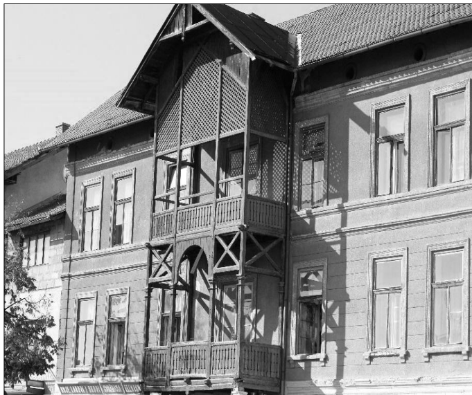
Zgrada Arhiva 2018. godine
