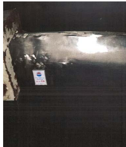
Slika 4 - Kavitaciono oštećenje na leđnoj strani, na izlaznoj ivici lopatice
