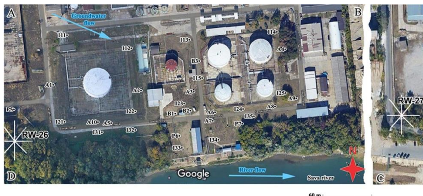
Сл. 2.5. Положај инјекционо-екстракционих бунара (I), пијезометара (P), локација (B), колона за филтрирање/адсорпцију/биореактор (A) и бунара радијалног колектора (RW) који се напајају у јавно снабдевање питком водом у области C
