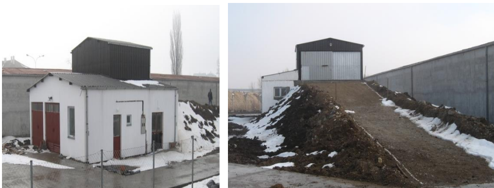
Слика 13.8. Регионални пункт за сакупљање нејестивих животињских нуспроизвода у Вршцу
