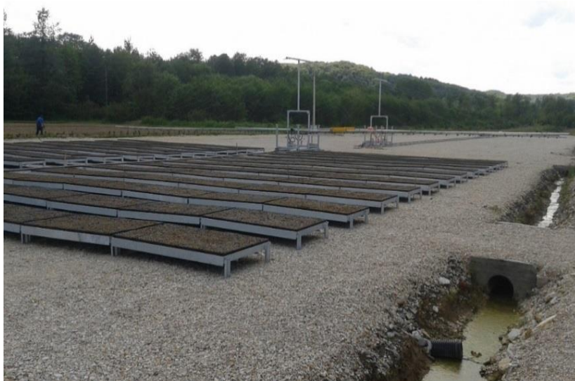
Сл. 12.3. Инсталација аутоматизованог система за заливање – Станови, Добој (Фото Цвјетковић Б 2017)
