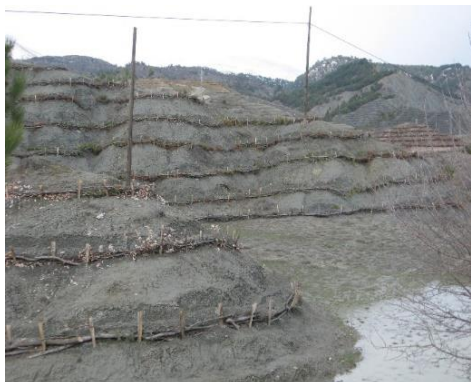
Сл. 12.6. Постављање баријера (Фото Sivaciöglu 2009) Fig. 12.6. Setting up barriers (Photo Sivaciöglu 2009)
