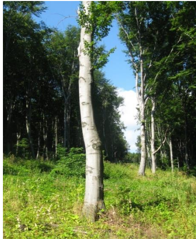
Сл. 3.3. Чишћење коридора за далековод (Фото Целетовић Ж) Fig. 3.3. The clearing power-line corridor (Photo Dželetović Ž)
