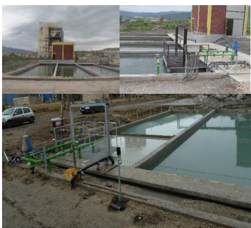
д) зграда за управљање расхладним системом воде за одшљакивање након реконструкције и расхладни базен након санације
