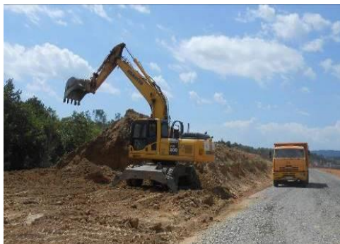
Сл. 10.16. Селективно откопавање плодног земљишта, привремено депоновање и разгртање плодног земљишта на површину депосола
