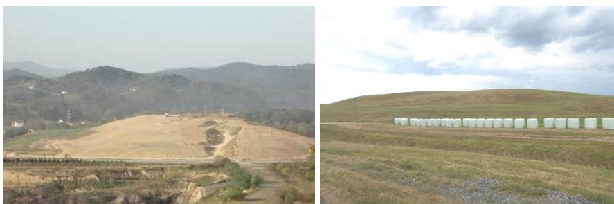
Сл. 10.15. Одлагалиште откритке са површинског копа Рашковац, Станари (зона Драгаловци): (1) завршетак обликовања и рекултивација, 2015. година; (2) коришћење истог одлагалишта у пострекултивационом периоду, 2020. година (Фото: Малић Н)
