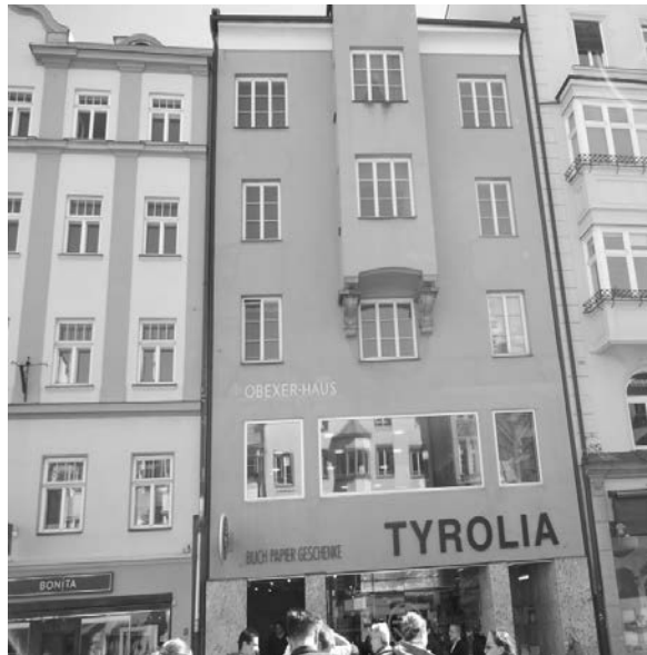
Zgrada u Insbrodu (natpis na fasadi: Obexerhaus ) (snimljeno 2013. godine)
