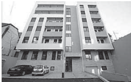
Slika 5. Doobar izgled zgrade (lux standard kat.)
