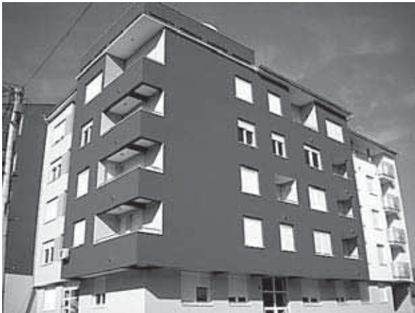
Slika 6. Standardan kvalitet izgradnje
