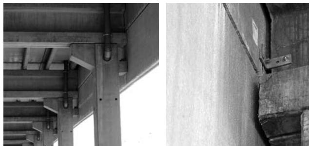
Ovakvo tehničko rešenje dovelo je do pojave ugaonih pukotina na panelima (pogledajte sliku ispod), jer nema dovoljno slobodnog prostora za ekspanziju unutar preseza metalnih profila.
