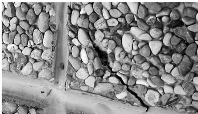
Problem se može rešiti zamenom ugaonih elemenata sa otvorima (prerezima) sa većim rupama, a radi pravilnog rada ovih fasadnih panela u smislu strukturne sigurnosti i izdržljivosti.
