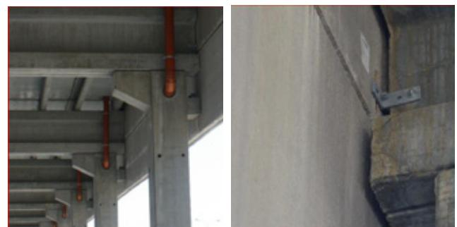
Ovakvo tehničko rešenje dovelo je do pojave ugaonih pukotina na panelima (pogledajte sliku ispod), jer nema dovoljno slobodnog prostora za ekspanziju unutar proreza metalnih profila.
