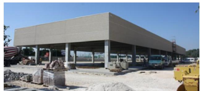
Na gornjoj slici prikazan je sistem povezivanja usvojen od strane kompanije koja je izgradila prefabrikovanu betonsku konstrukciju, pa je nije moguće samostalno revidirati, što je potvrđeno tokom inspekcije na terenu od strane sudskog veštaka. Na ovom primeru je vidljivo da nije obezbeđeno dovoljno pomeranje između glavne konstrukcije i fasadnih panela prilikom termičke ekspanzije.
