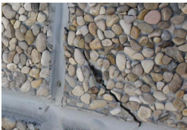
Problem se može rešiti zamenom ugaonih elemenata sa otvorima (prorezima) sa većim rupama, a radi pravilnog rada ovih fasadnih panela u smislu strukturne sigurnosti i izdržljivosti.
