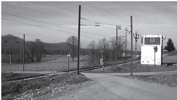
Neadekvatan ugao ukrštanja i trougao preglednosti
