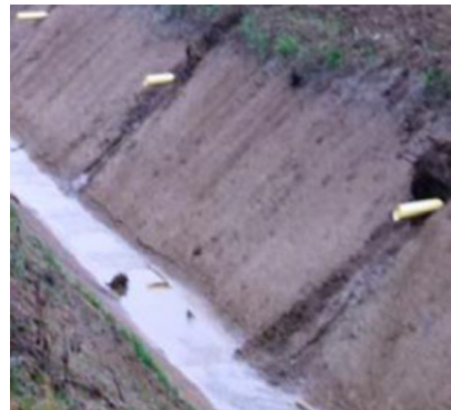
Slika 1 – Horizontalni drenovi za sniženje nivoa podzemnih voda
