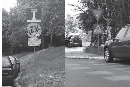
Slika 6. Primeri nepravilnosti saobraćajne signalizacije
