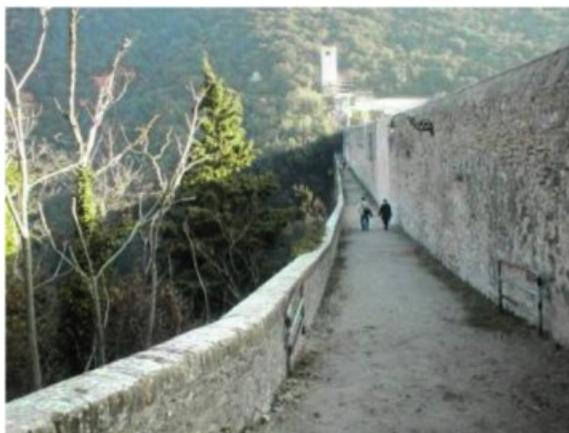
Fig. 4. Spoleto, Ponte-acquedotto, detto Ponte delle Torri, percorso stradale. L'alto muro contiene il canale per l'adduzione dell'acqua.
