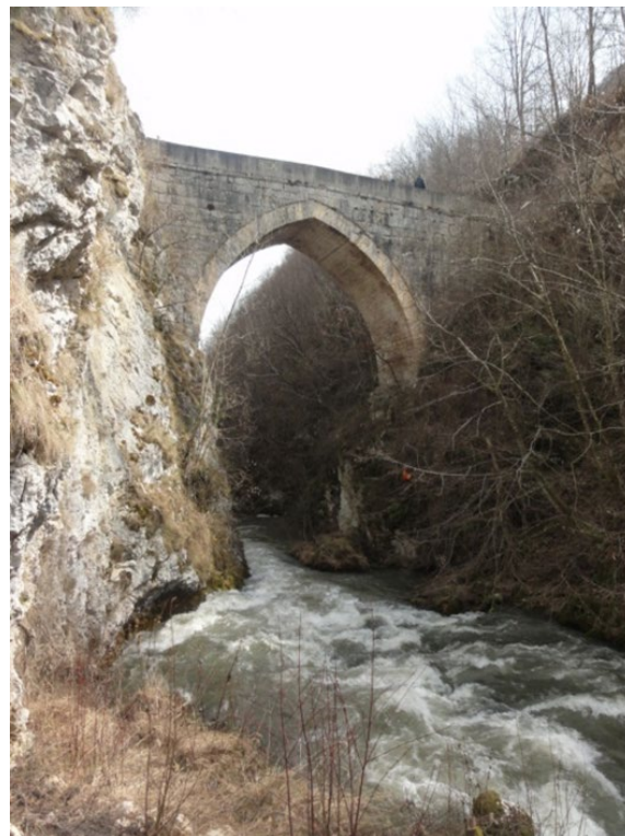
Слика 4. Мост на Жепи, низводни изглед
