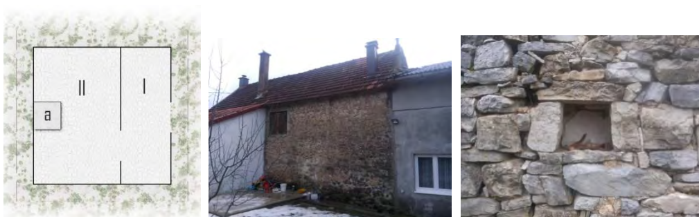
Слијева надесно: Слика 4. Основа спрата куле; Фотографија 5. Остатак куле бега Љубовића у селу Оџак код Невесиња, садашњи власници тврде да су затекли објекат са три спрата, срушили два и надоградиле прве двије етаже, зид је грађен као opus coementitium ; Фотографија 6. Удубљења у зиду за посуђе, полача Игњата Капора, село Мириловићи код Билеће.
