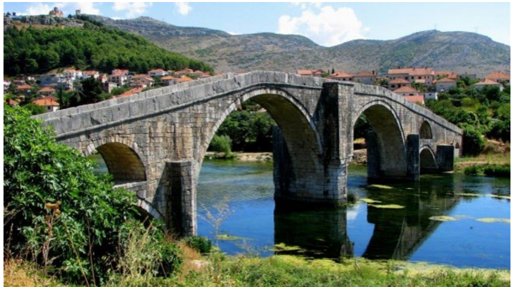
Слика 6. Мост преко Требишњице на новој локацији
