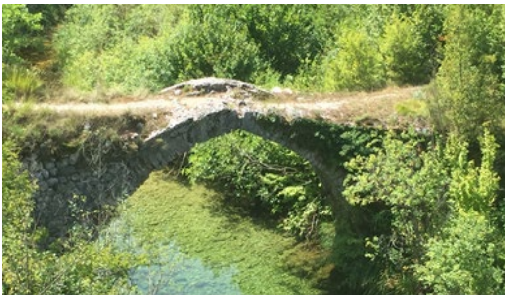
Слика 9. Мост на ријеци Сушици у Вучјој
