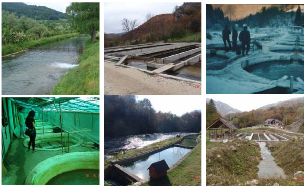
Сл. 5. Различити типови базена (земљани, бетонски, каналски, правоугаони, ротациони), постављени у серији или паралелно Different types of pools (earthen, concrete, rectangular, rotating), placed in series or in parallel
