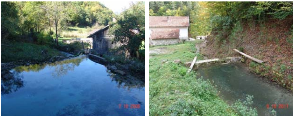
Сл. 2. Водозахват Water intakes
