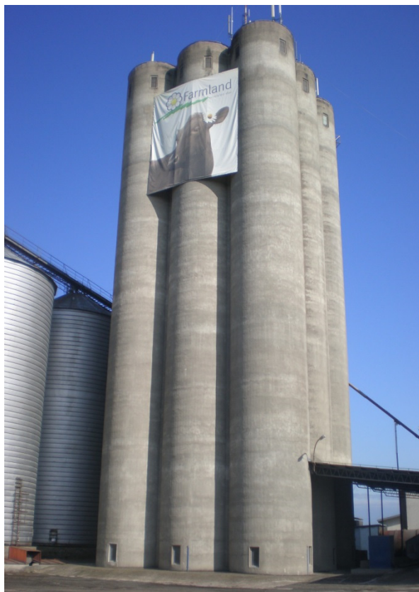
Сл. 3. Бетонски силоси Concrete silos
