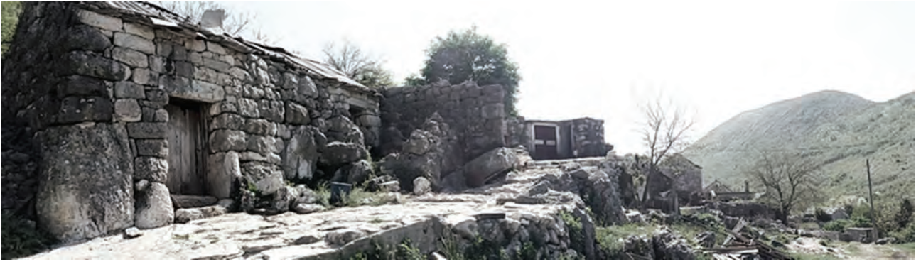
Сл. 3. Камене куће села Увјећа (Фото: Чворо, 2018) Fig. 3. The village Uvječa's stone house (Photo: Čvoro, 2018)
